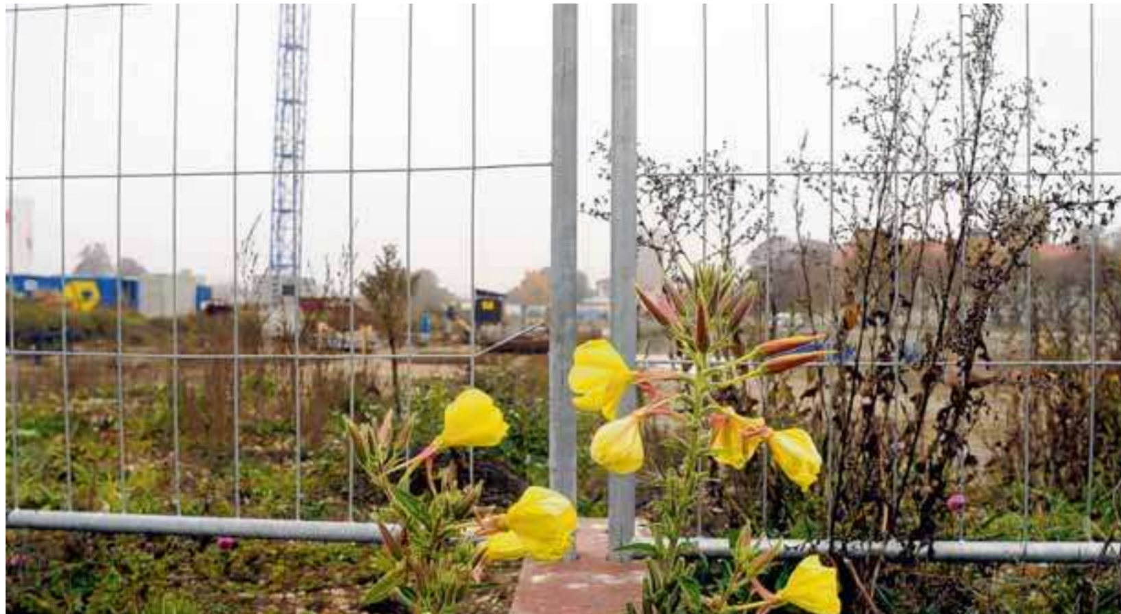
In den vergangenen Monaten dominierten auf dem Reese-Gelände die Abbruchbagger. Jetzt zeugt der erste Kran von den beginnenden Hochbauarbeiten. Zunächst entstehen entlang der Langemarckstraße im Westen verschiedene Wohnhäuser. Fotos: Ruth Plössel
