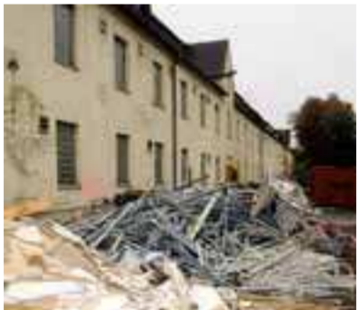
Die letzten Überbleibsel der Flak-Kaserne werden derzeit abgebrochen.
